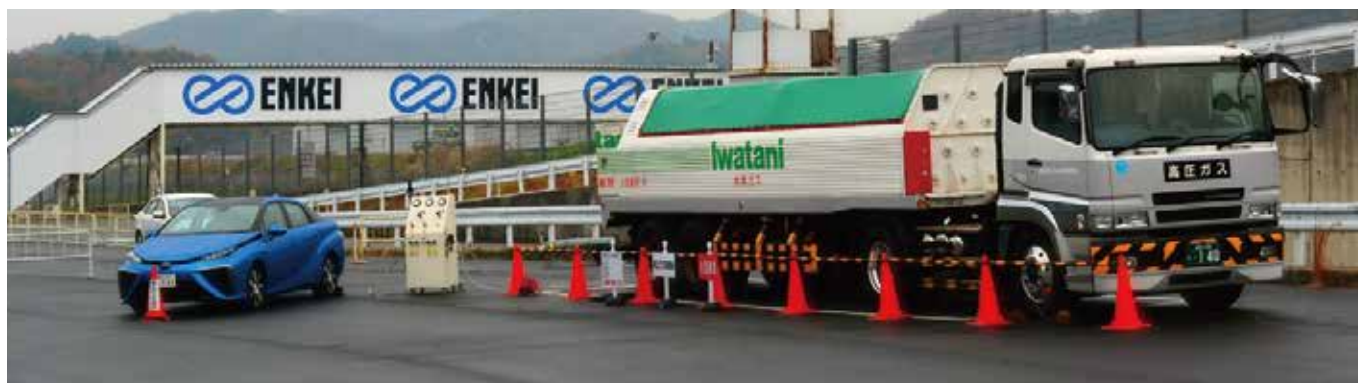
写真：水素トレーラーを使用した簡易移動型小型水素充填装置から FCV への充填の様子
